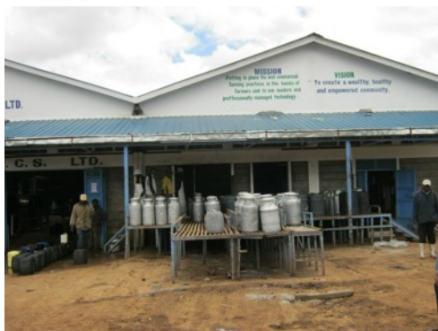
Coopérative Nyala – Installation de refroidissement
